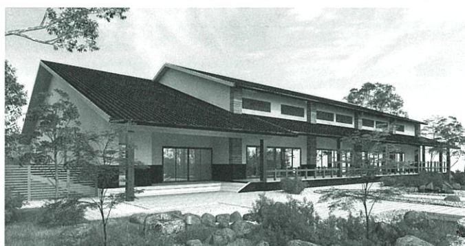
積628.95平方メートルで建設。剣道競技場施設基準に準拠する剣道競技場を2面（1面11×11m）設ける他、師範控室、更衣室、シャワー室、トイレ等施設も完備。競技場の床材は厚さ45mmの秋田杉を使用、床下には、競技場の四隅と中央に、1面5個の瓶（かめ）を埋め込み、踏み込む足の音と共に鳴させる。瓶は鹿児島の焼酎醸造メーカーから譲り受けたもので、高さ約90cm、胴回り約70cm、口径約60cm。
